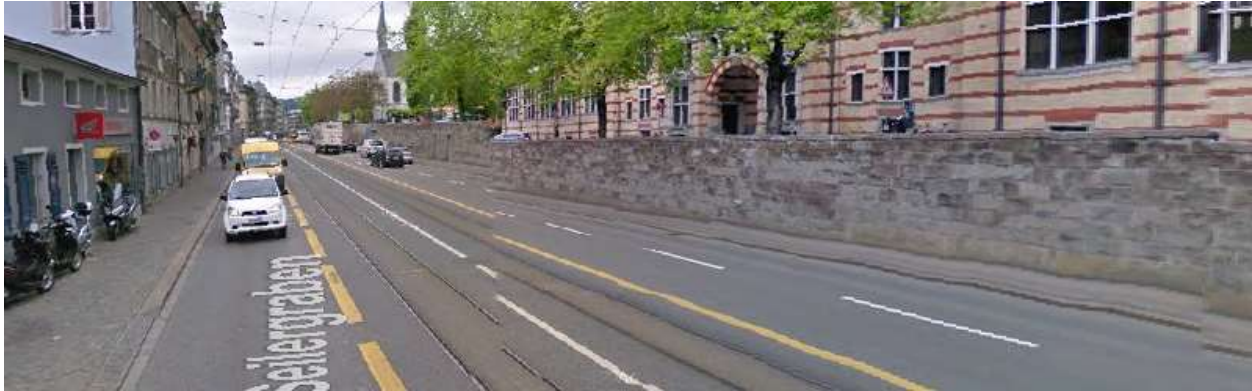
Seilergraben und Hirschengraben, 8001 Zürich.
